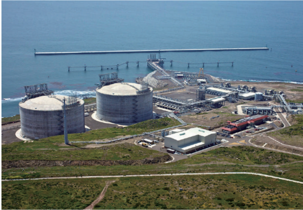
ECA LNG PJT 현장
