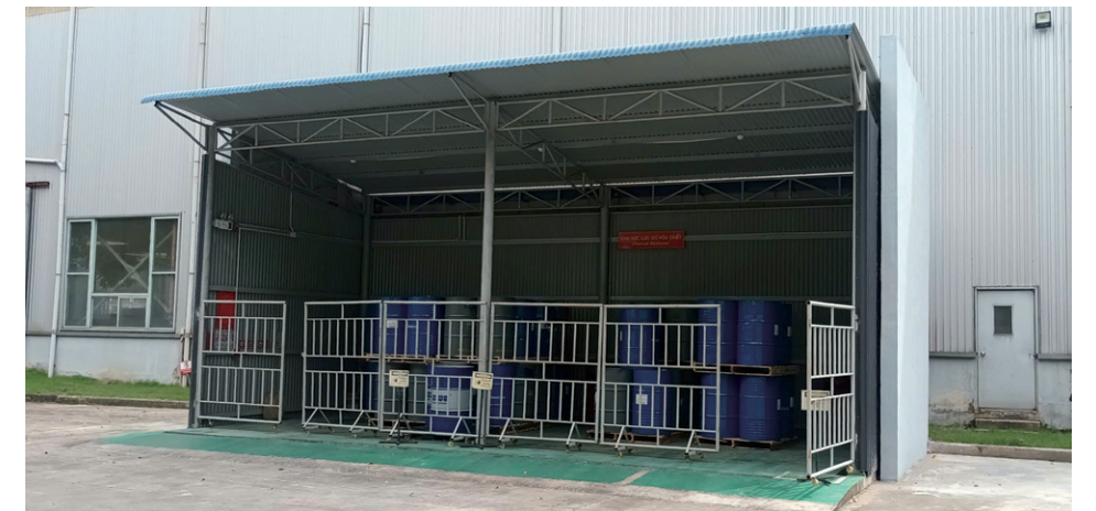
화학창고 개보수 및 신축(SeAH Steel Vina)
