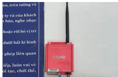
화재경보 송신 시스템(SeAH Steel Vina)
