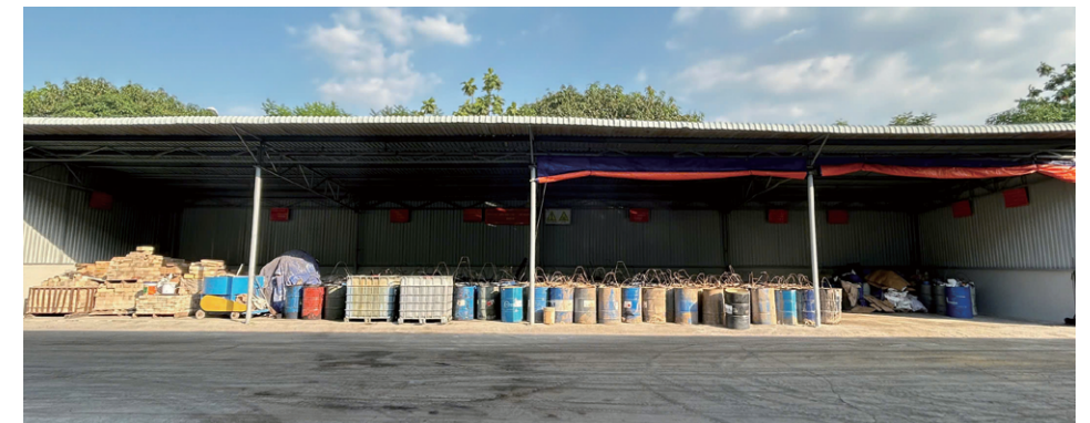
Bien Hoa 공장 신축(SeAH Steel Vina)
